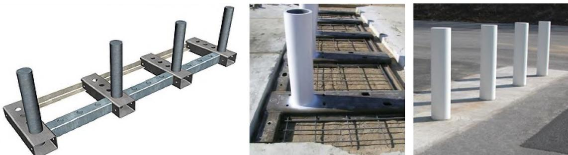
**Рис. 1. Рациональная форма конструкции безбарьерного пешеходного ограждения и способ ее установки**
